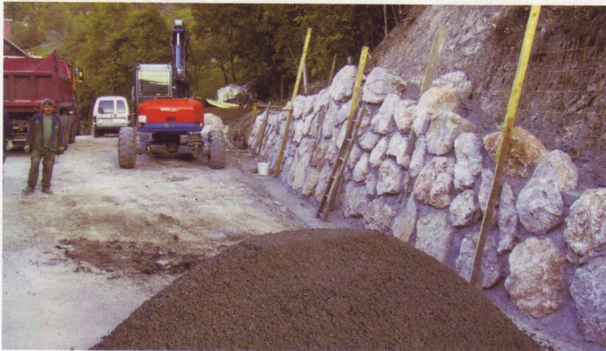
V Žirovnici gradijo kamnito-betonske oporne zidove.
